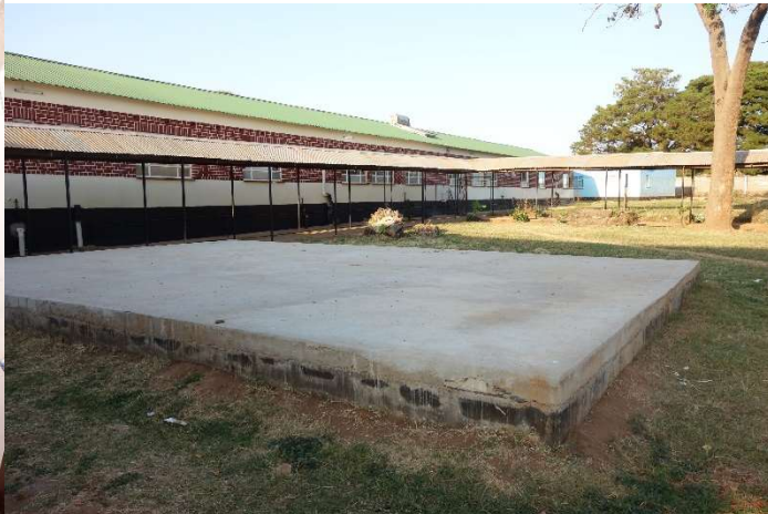
Fundament für Container
