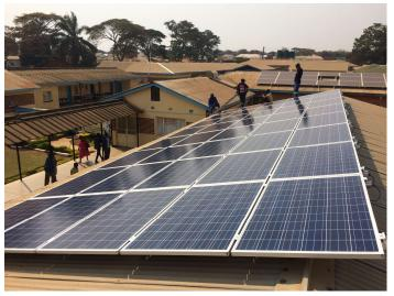
Zudem wurden die beiden Anlagen miteinander verbunden, was zu einer höheren Ausfallsicherheit führte. Angeschlossene Verbraucher können je nach vorhandener Kapazität auf Grund von definierten Prioritäten ausgeschaltet resp. am Netz belassen werden. Zum Beispiel der Operationssaal, der die höchste Priorität für eine Stromzuteilung bei Stromausfall hat, kann so für lange Zeit (>3 Tage) mit Notstrom versorgt werden.
